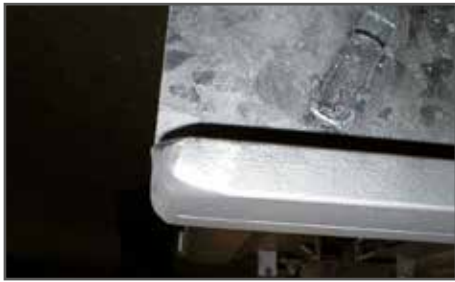
sivukiskon laakeripinta on pyöristetty
